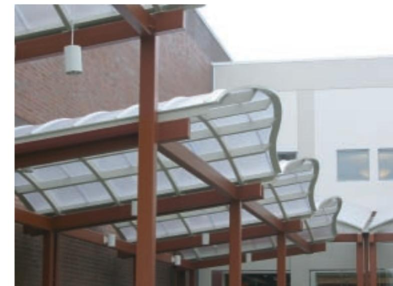
**BDL system** è utilizzato per la realizzazione di coperture curve. Il sistema, completo di ogni accessorio, prevede la fornitura sia delle banchine laterali sia dei timpani permettendo di realizzare cupolini autoportanti. Nel caso in cui la luce e il carico siano eccessivi, occorrà prevedere una sottostruttura.
